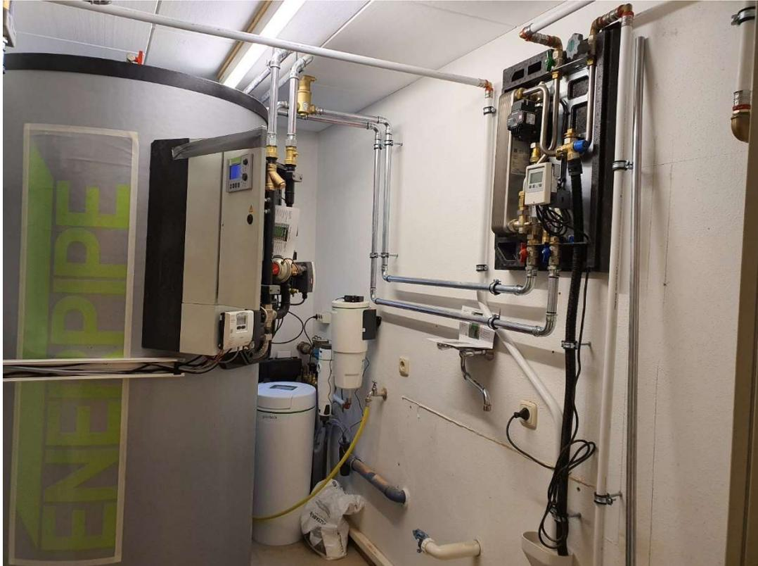
Unsere neue Übergabetechnik von der Firma Enerpipe, mit Pufferspeicher, Übergabestation und Frischwasserstation
