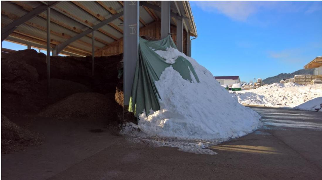
Das ist ein einfaches Vlies, welches mit Schraubzwingen an den Trägern befestigt wurde
